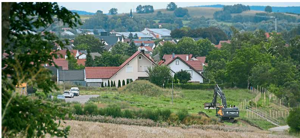
Auf der Erweiterungsfläche des Baugebiets „Nordwestlich von Pförring“ haben die Erschließungsarbeiten begonnen. Die VG hat jetzt den Auftrag für den Kanalbau zum Preis von knapp 900.000 Euro vergeben. Die Gesamtkosten inklusive Kanal und Wasserleitung belaufen sich auf 1,9 Millionen Euro. Foto: Kügel
